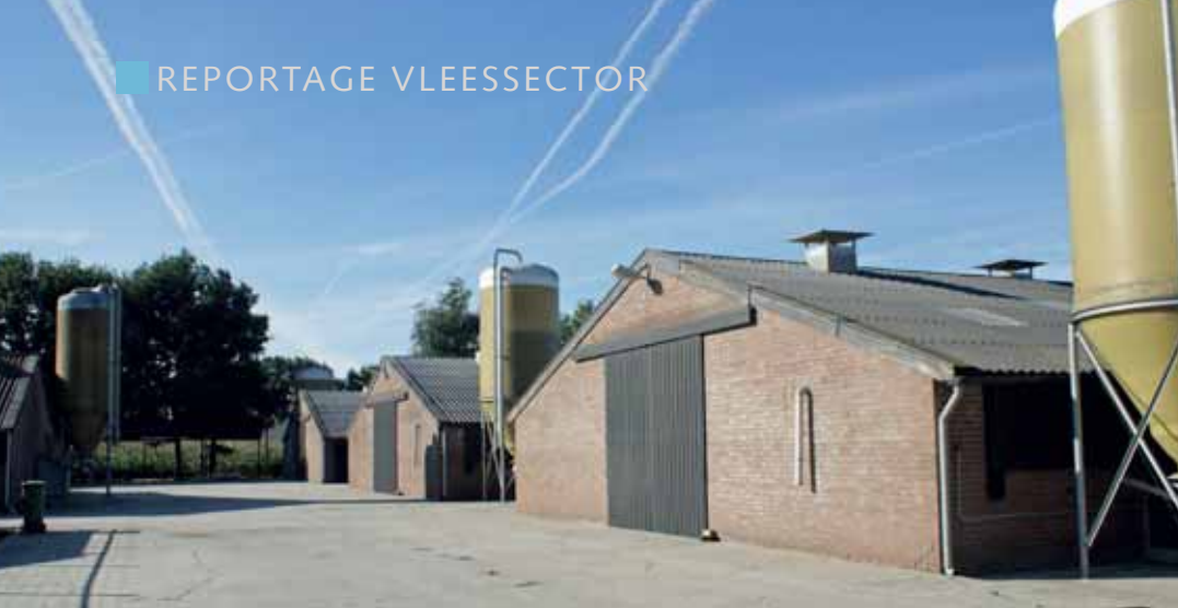
Van Bommel verbouwde de voormalige opfokstallen om voor scharrelvleeskuikens, plaatste lichtplaten en een overdekte uitloop
